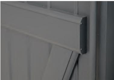
Fixation du cache par rivet.
