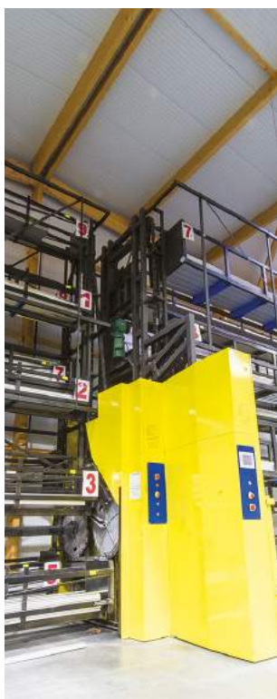
Achat et stockage de la matière première
